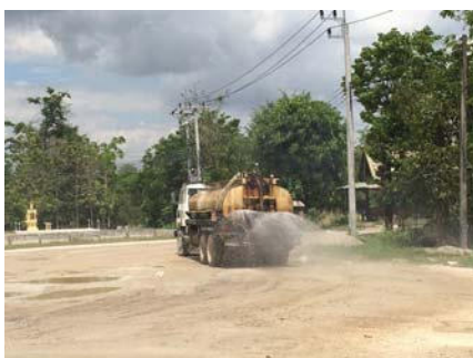
รูปที่ 2-15: การฉีดพรมน้ำบริเวณเส้นทางขนส่งแร่
